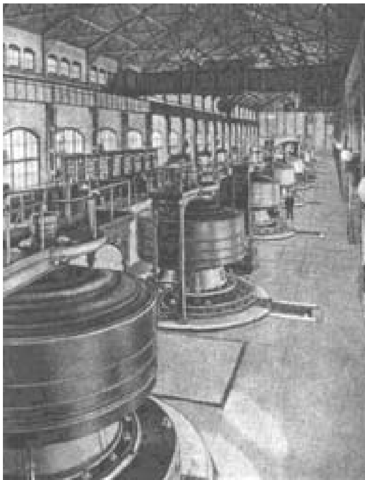
Турбинный зал Ниагарской электростанции. Фотография. Конец XIX в.
